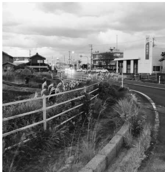
電動カートも通れない歩道
